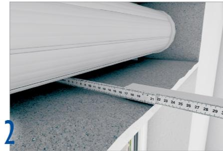
2. Messen Sie den Kasteninnenraum, um die Länge und Stärke der Dämmplatten festzulegen.
